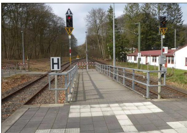
Abbildung 6: Im Bereich der FVE erfolgen alle Bahnsteigzugänge über Rampen. Notwendige Gleisquerungen sind niveaugleich und stufenfrei angelegt.
