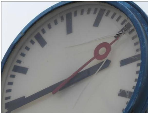
Abbildung 20: An der Bahnsteiguhr in Bremen-Hemelingen war einseitig das Glas beschädigt. Die Uhrzeit wurde korrekt angezeigt.
