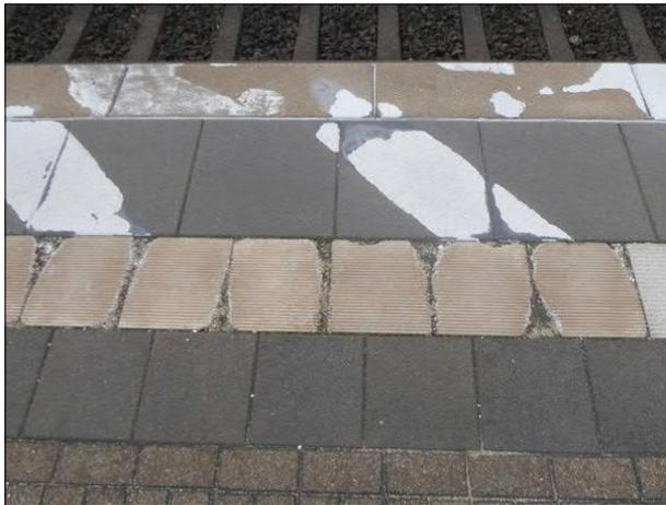
Abbildung 7: In Bremen-Walle sind einige Platten der Blindenleitstreifen auf dem Bahnsteig beschädigt. Außerdem platzt die Gefahrenbereichsmarkierung bereichsweise ab.
