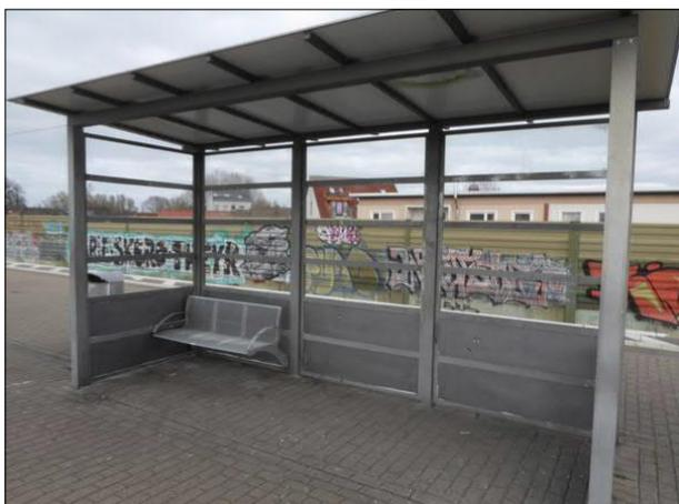
Abbildung 11: Im Unterstand in Bremen-Walle fehlten 15 Scheiben. Zudem waren eine weitere Scheibe und die Brüstung beschädigt.
