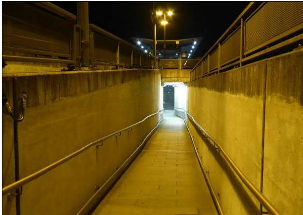
Abbildung 49: An der Rampe zum Bahnsteig in Bremen-Oslebshausen wurden sämtliche Fliesen von den Wänden entfernt.
