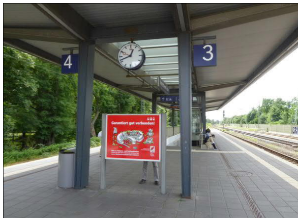
Abbildung 47: In Bremerhaven-Lehe wurden an zwei ehemals doppel seitigen Vitrinen feste Rückwände eingebaut. Diese wurden beklebt, um Schmierereien vorzubeugen.
