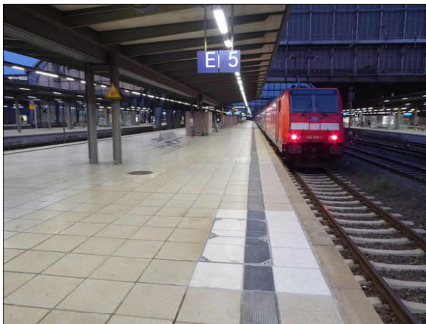
Abbildung 7: In Bremen Hbf sind an Gleis 5 bereichsweise die Bahnsteigplatten erneuert worden. Angehobene Platten und Schäden an den Fugen gab es dort in diesem Jahr nicht mehr.
