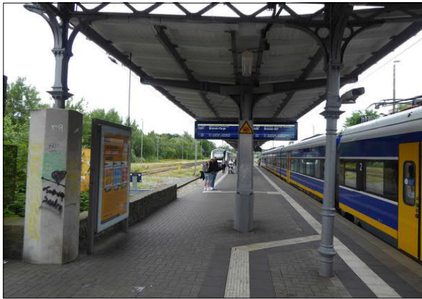
Abbildung 22: Am Hauptzugang auf den Bahnsteig in Bremen-Vegesack fehlen Gleisnummernschilder. Diese befinden sich erst am Ende des Bahnsteigdaches. Bis zur Softwareumstellung wurden die Gleisnummern in den Zugzielanzeigern abgebildet.
