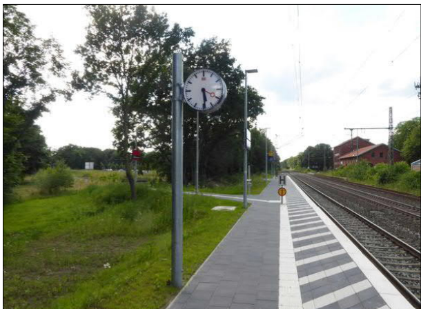
Abbildung 19: In Bremen-Oberneuland sind im Zuge der Bahnsteigerneuerungen wieder Bahnhofsuhrn installiert worden.
