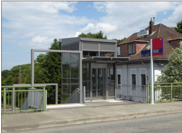
Abbildung 4: Zur barrierefreien Erreichbarkeit des Bahnsteigs ist in Bremerhaven-Wulsdorf direkt neben der Bahnsteigtreppe ein Aufzug gebaut worden.
