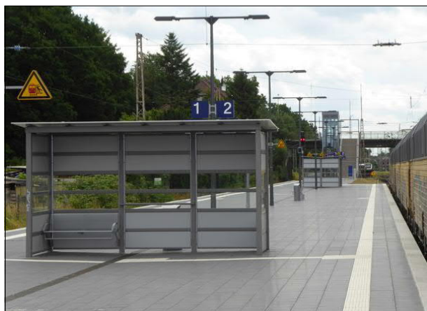
Abbildung 2: Nachdem der Bahnsteig in Bremerhaven-Wulsdorf bereits im letzten Jahr erneuert wurde, ist in diesem Frühjahr mit der Inbetriebnahme des Aufzugs die Modernisierung der Station abgeschlossen worden.
