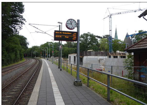
Abbildung 42: Der seit Jahren ungenutzte und vernachlässigte Güterschuppen in Bremen-Blumenthal wurde aberissen. Der an dessen Stelle begonnene Neubau wird das Umfeld der Station aufwerten.
