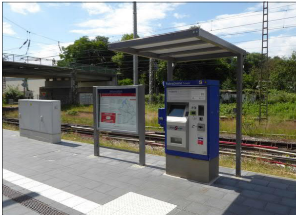
Abbildung 31: Der Fahrkartenautomat in Bremerhaven-Wulsdorf wurde mit einer Überdachung ausgestattet.
