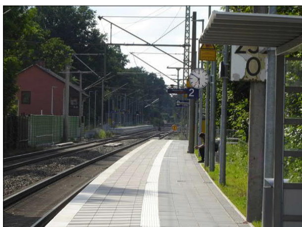
Abbildung 3: Die im letzten Jahr begonnene Erneuerung der Bahnsteige in Bremen-Oberneuland wurde in diesem Jahr fertiggestellt.
