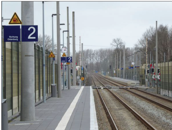
Abb. 1: Am 14. Juni 2020 wurde die neu eingerichtete Station Jaderberg mit ihren am Bahnübergang der Vareler Straße versetzt angeordneten Außenbahnsteigen in Betrieb genommen. Auf ganzer Länge prägen hohe Lärmschutzwände das Bild.
