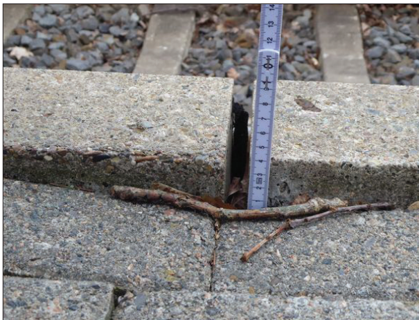
Abb. 8: Der Bahnsteig in Sellstedt wies stellenweise Absackungen mit Stufenbildung bis zu 4 cm Höhe auf.
