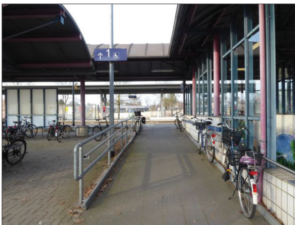
Abb. 42: Trotz coronabedingt auch in Achim ausreichend vorhandener Fahrradabstellmöglichkeiten waren einzelne Räder an den Handläufen des barrierefreien Zugangs zu Gleis 1 angeschlossen.
