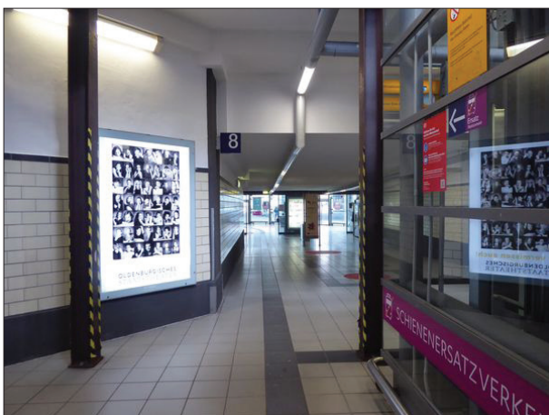
Abb. 45: Im Tunnel des Oldenburger Hauptbahnhofs wurde der bröckelnde Blindenleitstreifen erneuert.
