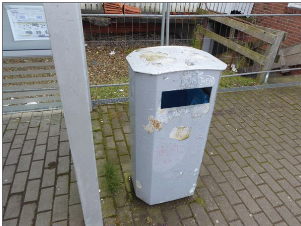
Abb. 20: Die Mülleimer auf dem Bahnsteig von Ganderkesee weisen teilweise größere Lackschäden auf.
