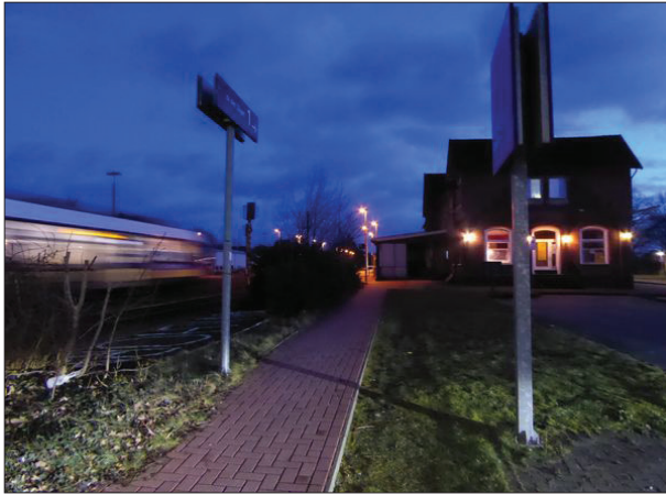
Abb. 46: In Ahlhorn ist der mehr als 30 m lange Weg vom Bahnübergang zum Bahnsteig an Gleis 1 unbeleuchtet.
