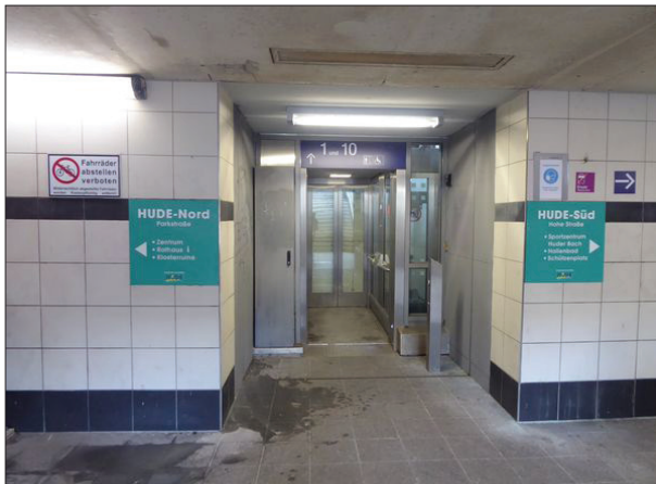
Abb. 28: In Hude wurde in der Unterführung eine innerörtliche Wegeleitung installiert. Außerdem wird die Richtung zum Schienenersatzverkehr ausgewiesen.
