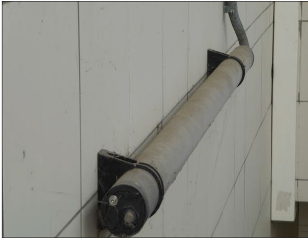
Abb. 47: Wie vor zwei Jahren waren an mehreren Stationen Leuchten an Treppenaufgängen stark verschmutzt. Diese Leuchte ist in Twistringen installiert.
