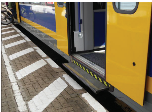
Abb. 5: Nur wenige Wochen nach der Qualitätserhebung wurde mit der Erneuerung und der Anhebung der Bahnsteige in Heidkrug begonnen, um einen stufenlosen Einstieg in die S-Bahnen herzustellen.
