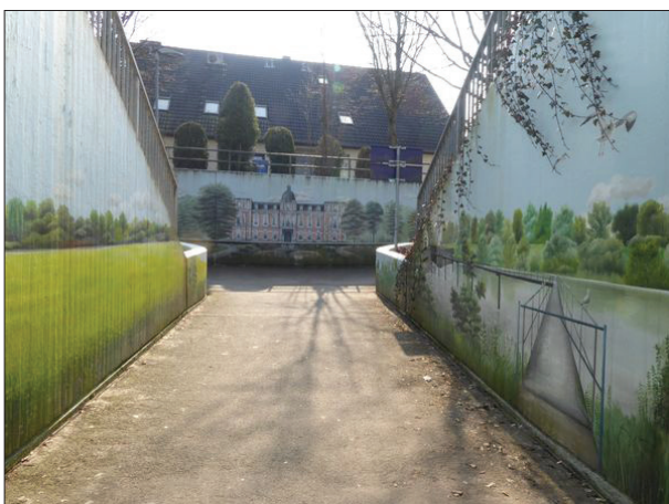
Abb. 60: Die mit Motiven liebevoll gestalteten Betonwände der Rampen und des Tunnels in Etelsen heben sich sehr positiv von den meisten anderen Stationen ab.
