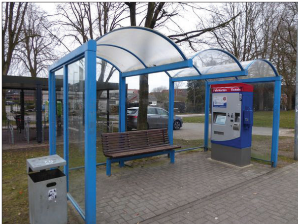
Abb. 17: Der Unterstand in Wehdel war sauber und wies nur kleine Lackschäden auf. Eine Dachscheibe war angekokelt.
