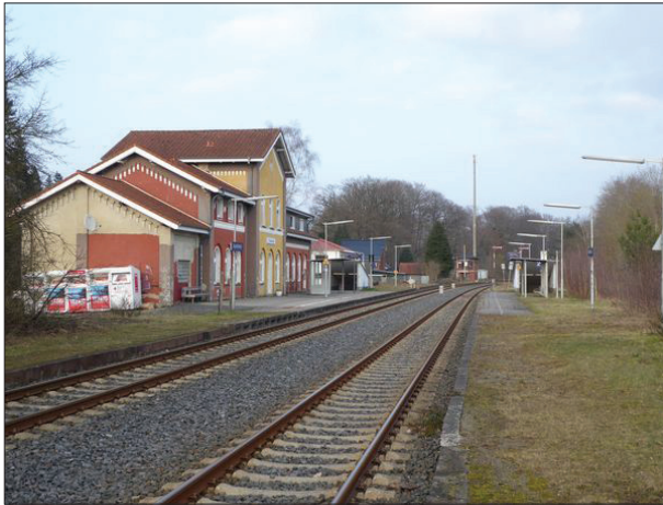
Abb. 7: Mit der Erneuerung der seit Jahren baufälligen Bahnsteige in Visselhövede wurde rund zwei Monate nach der diesjährigen Qualitätserhebung begonnen.
