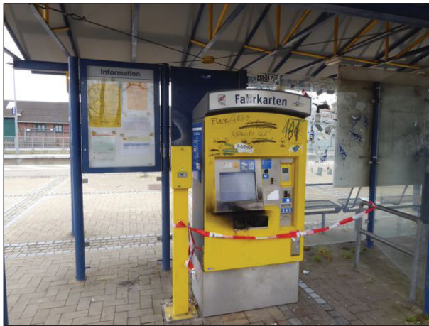
Abb. 37: In Ottersberg war einer der beiden Fahrkartenautomaten an Gleis 1 durch einen Brandschaden nicht betriebsfähig.
