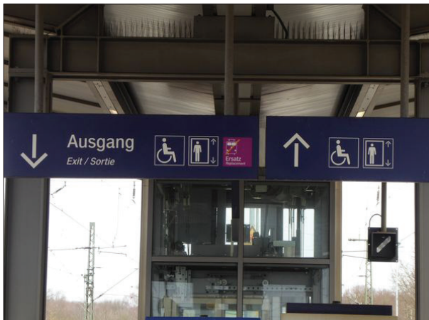
Abb. 29: Die Ausgangswegeleitung vom Bahnsteig in Osterholz-Scharmbeck ist nicht korrekt. Der Treppenabgang ist für Rollstuhlfahrer ungeeignet.
