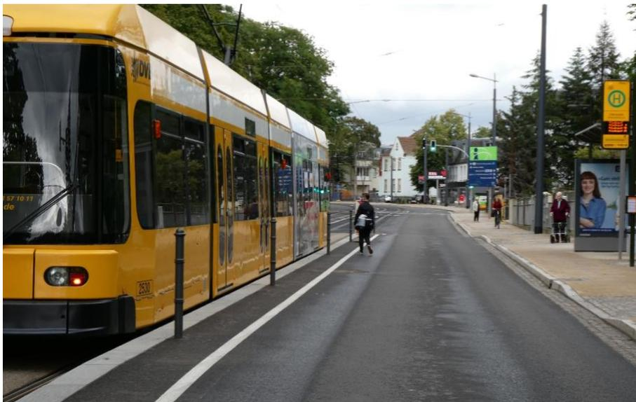
**Bild 40: Beispiel für eine Straßenbahnhaltestelle mit angehobener Fahrbahn für niveaugleichen Einstieg (Foto: Anke Baute, SKUMS)**
