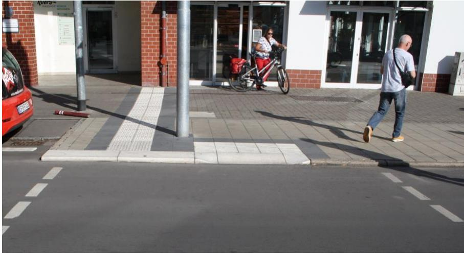
**Bild 31: Beispiel für eine getrennte Überquerungsstelle mit differenzierter Bordsteinhöhe (Foto: VE Kass GmbH)**
