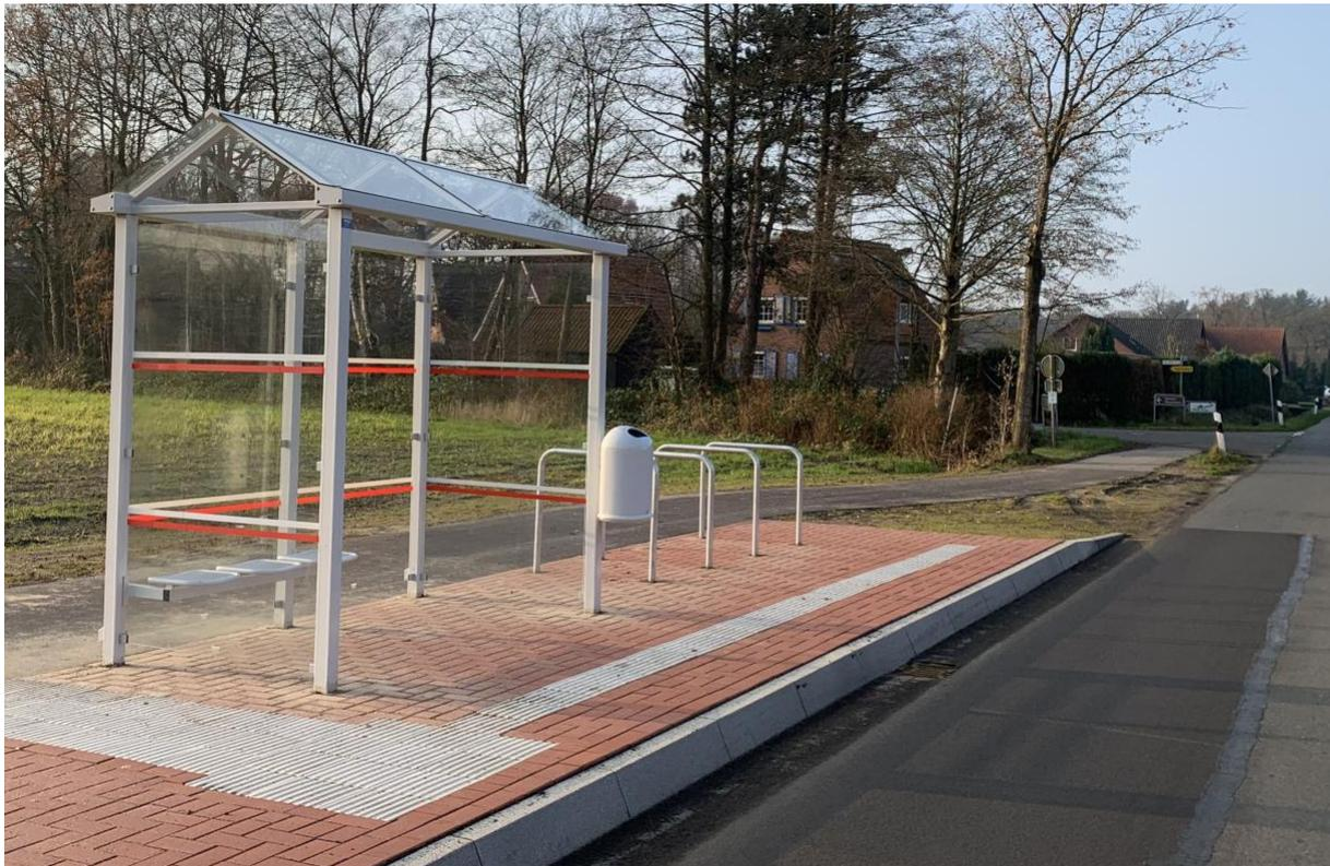
**Bild 37: Ausführungsbeispiel für eine visuell kontrastierende Wechselmarkierung auf der Glasfläche eines Fahrgastunterstands (Foto: Rode-Matis/ZVBN)**
